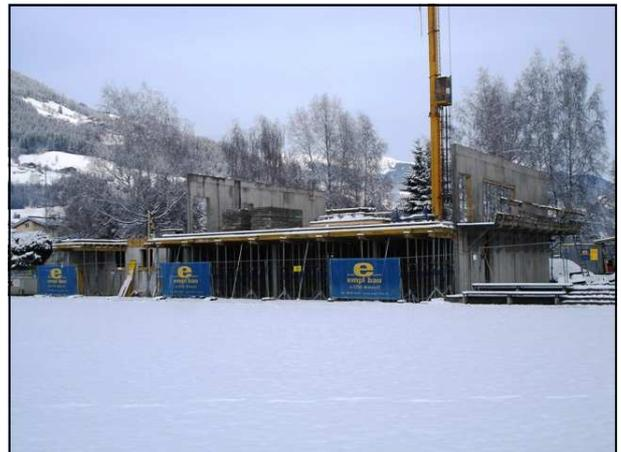
**05.12.2009 Die Obergeschossdecke wird betoniert und die Seitenflügel werden aufgezogen.**
