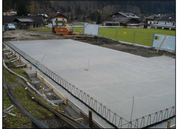
**08.11.2009 Betonieren der Bodenplatte.**
