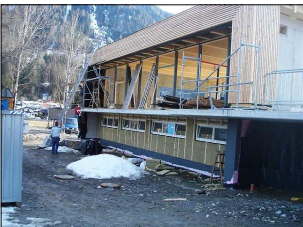
**17.03.2010 Die obere Glasfassade ist montiert, die Außenfassade wird verschalt.**
